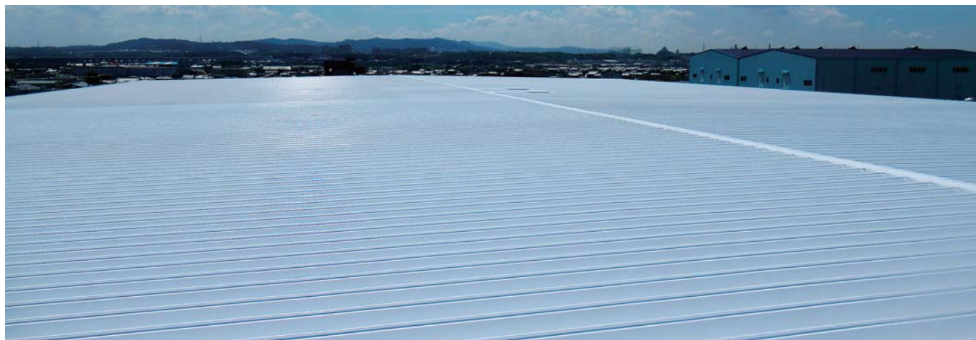
▲遮熱・断熱塗料「クールサーム」を塗布した屋根
