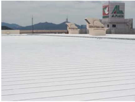
㈱平和堂 アル・プラザ亀岡店 施工年月:2013年7月 面積:9,000㎡(折板屋根) 夏季の空調電力使用量15%削減。
