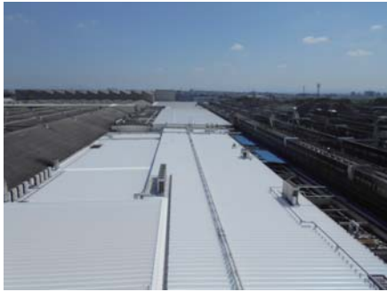
㈱豊田自動織機 長草工場 施工年月:2019年8月 面積:19,000㎡(折板屋根)
