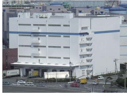
冷凍物流倉庫 施工年月:2006年2月 面積:6,200㎡(外壁) 電力消費量を前年度比で、年間18%削減。
