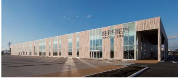
函館 蔦屋書店 施工年月:2017年7月 面積:5,075㎡(屋上防水面) 店内温度5℃低下。空調の効きが良くなった。
